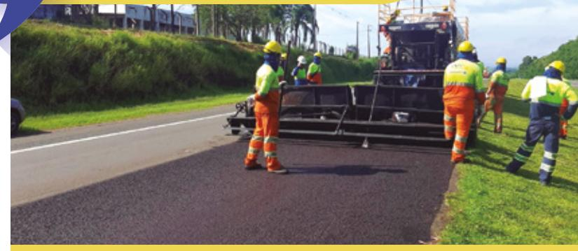
Utilizamos tecnologia sustentável na revitalização do pavimento da SP 310 – Rodovia Washington Luís. A aplicação deste asfalto leva em sua composição borracha moída proveniente da reciclagem de pneus usados. O material é até três vezes mais durável que o asfalto convencional.
